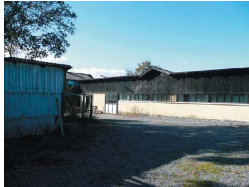
Lager- og værkstedsbygning
